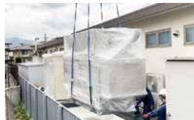
設置工事の様子。
